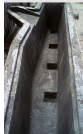
Beton-Dauerfutter Garnissage du béton permanent
