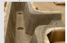
Permanent lining of tundish Garnissage du béton permanent
