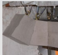
Suspended roof of dryer Voûte suspendue de sécheur
