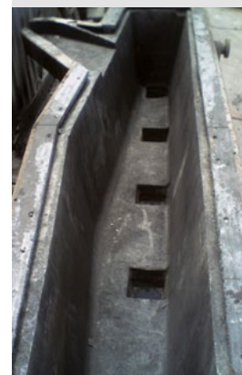
Permanent lining of tundish Garnissage du béton permanent
