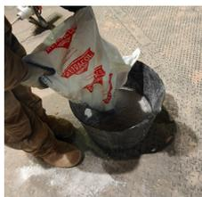
Verser la totalité du sac de Refravibre H800 Series (A) dans un bac de mélange
