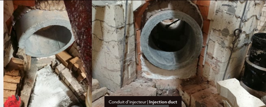
Conduit d'injecteur | Injection duct REFRASIC 214 S
