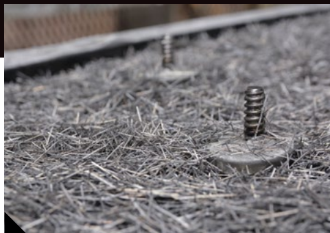
1 Mise en place des fibres
