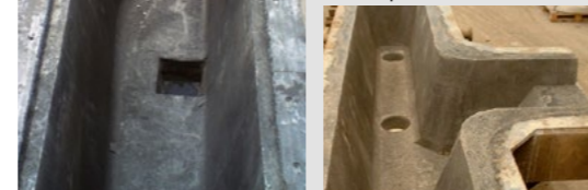
Permanent lining of tundish Garnissage du béton permanent Permanent lining of tundish Garnissage du béton permanent
