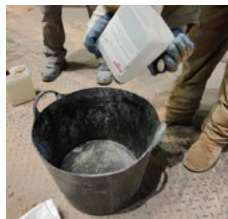
Vider l'intégralité du bidon de liant (B) dans le bac
