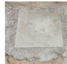
Exemple d'application : Blocage de dalle d'impact
