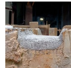
Exemple de réparation : Bec de répartiteur
